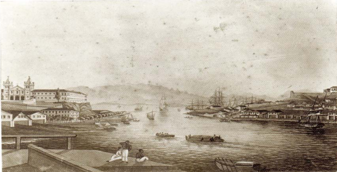
Figura 7- Vista do canal da Ilha das Cobras e do morro do Mosteiro de São Bento. Desenho a nanquim aquarelado em sépia 89 .
